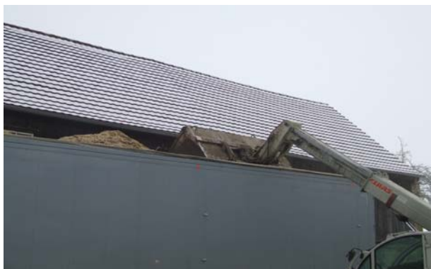
Bild 7: es wird noch mal verdichtet und nach Anweisung des Fahrers die endgültige Füllhöhe hergestellt (Plane muss noch schließen) .....
